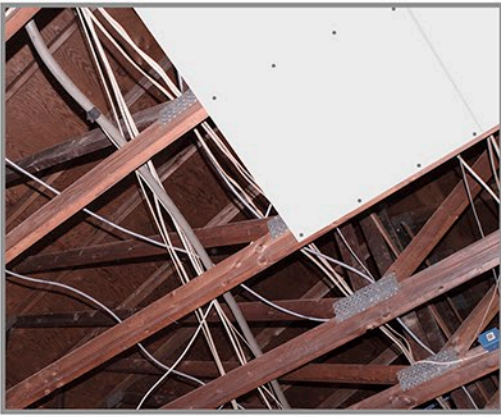
Step 1- Install Drywall
